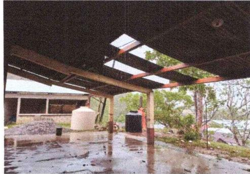
Foto 2: El techo del corredor fué dañado por una tormenta de lluvia y viento. Con la ayuda de los padre se logró reemplazar algunas laminas; se considera oportuno realizar el cambio.
