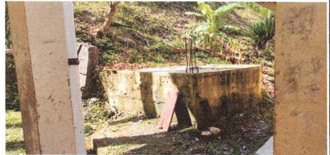
**Foto 4:** Repello y mantenimiento de la base de los tinacos y se colocará un techo de losa. Mismo que servirá para color los tinacos existentes en el establecimiento, y poder captar agua para los servicios de higiene.
