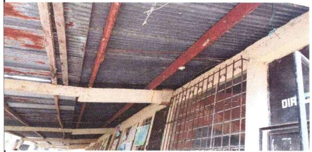
Foto 4: Se desea pintar costaneras para evitar que se siga oxidando. Asi mismo, pintar las paredes interior y exterior.
