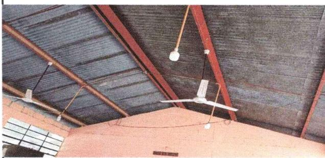
Foto 5: Reparación del sistema electrico, en todo el area debido a constantes corte circuitos. Hasta el momento se distribuye energia a traves de extensiones, electricos.
