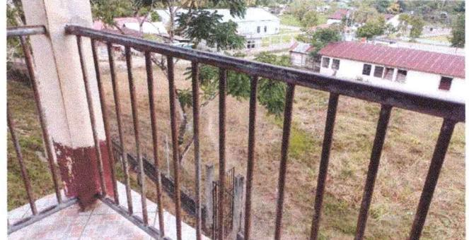
**Foto 2:** Barandas despintadas y se necesitan darle mantenimiento para evitar que se siga oxidando.
