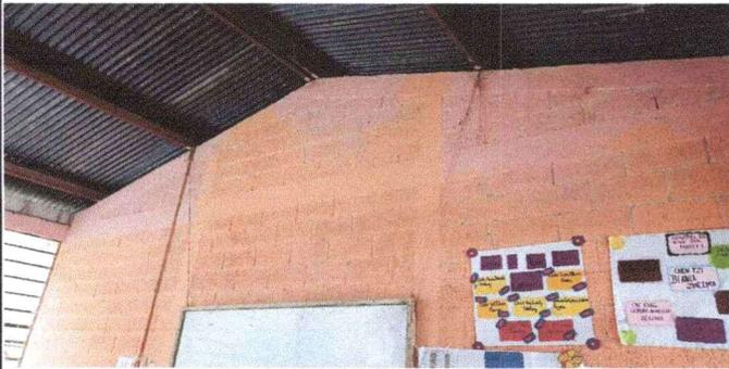
**Foto1:** Pintar paredes interior y exterior, debido a que se encuentra despintada y paredes en mal estado de las aulas.
