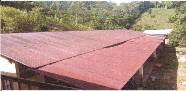
Foto1: Cambio de techo porque se encuentra con mucho oxido y filtración de agua.
