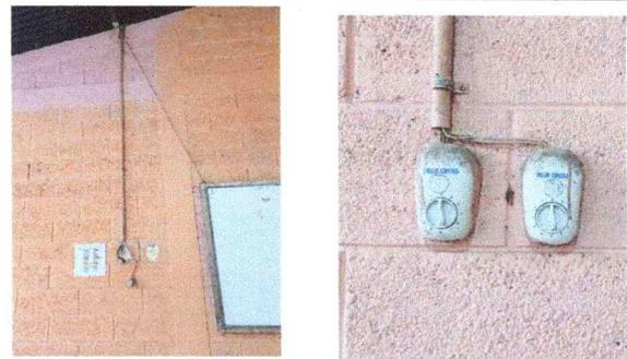
Foto 6: Reemplazar ventiladores, otros accesorios de energia electrica, tales como: toma corriente, apagadores, plafoneras y bombillas.
